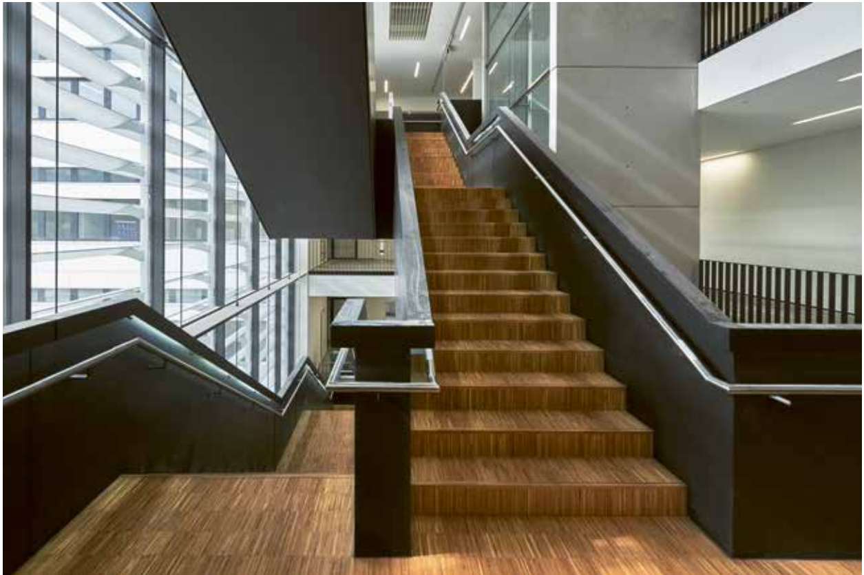
Neubauten V und W, Bergische Universität, Wuppertal
