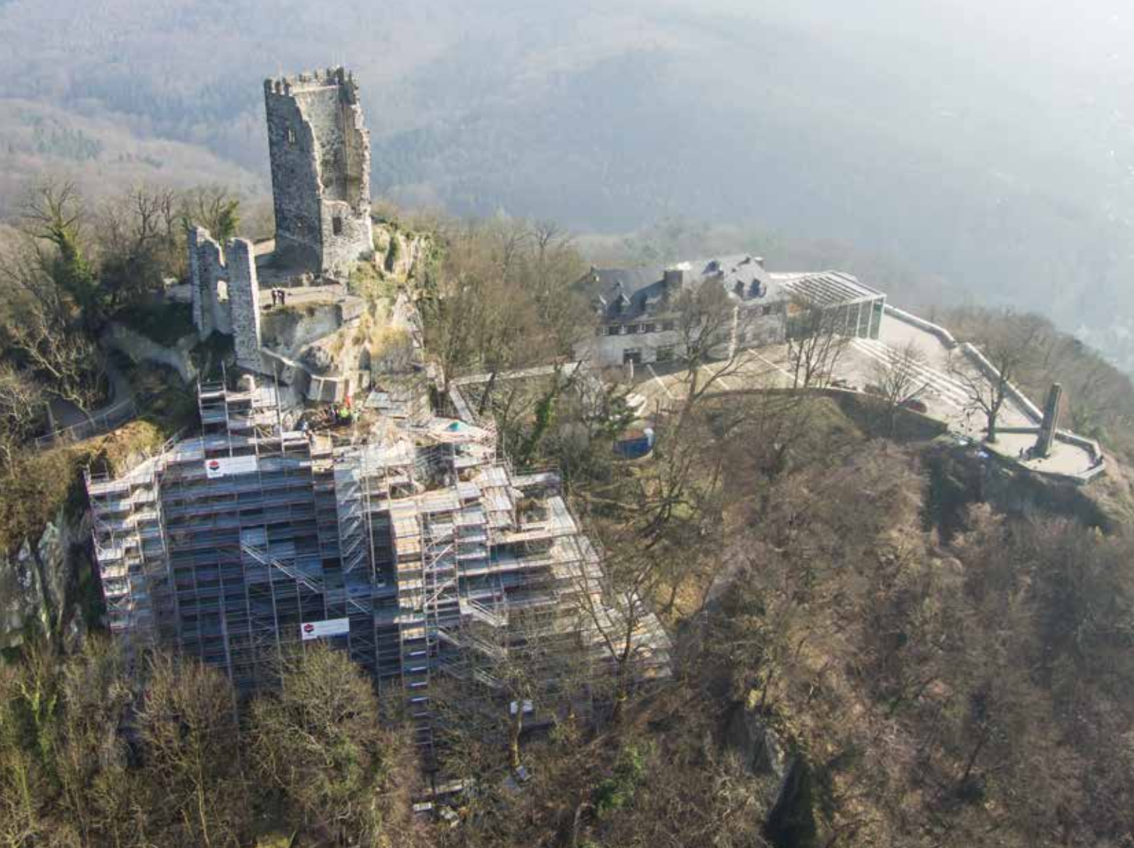
Sanierung Drachenfels, Königswinter
