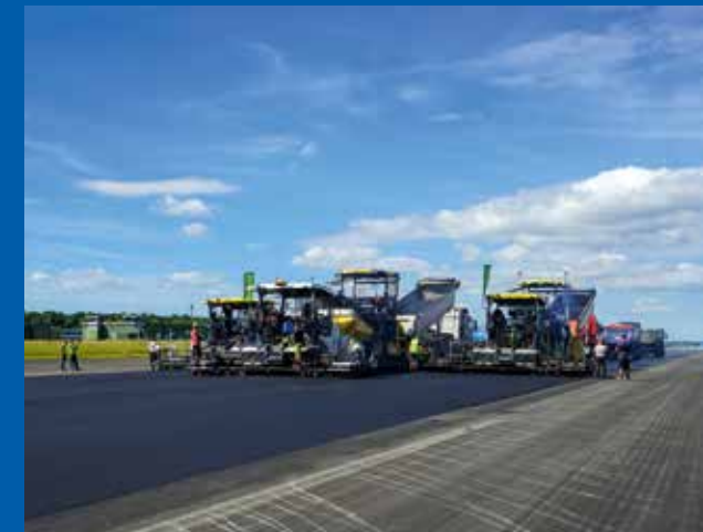
Asphaltfertiger im Einsatz: Mit schwerem Gerät wurde die Start- und Lande-Bahn erneuert.
