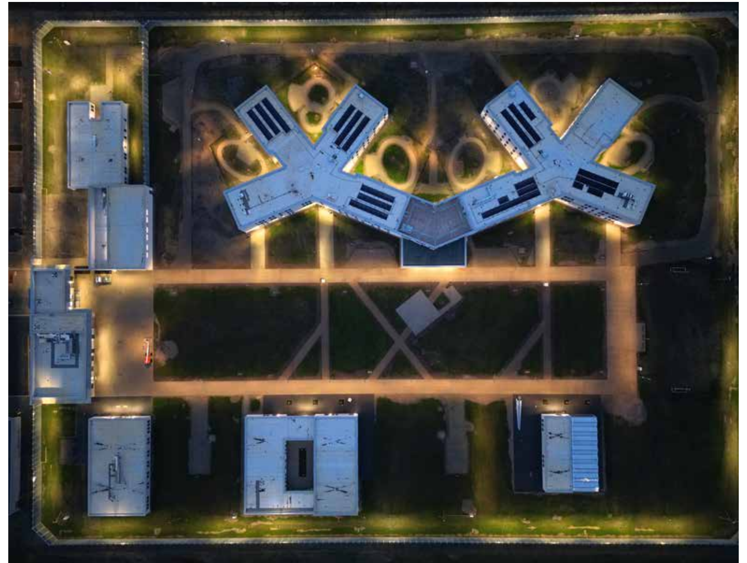
Für die forensische Psychiatrie in Hörstel sind auf dem 60.000 m² großen Grundstück elf Gebäude errichtet worden.
