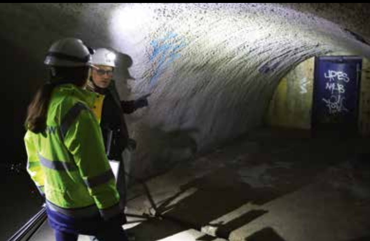
Ein alter Zugang zu den Stollen: Oberirdisch sind inzwischen fast alle Eingänge im öffentlichen Raum versiegelt worden.
