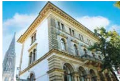
Das Freiherren-von-Vincke-Haus mit Fassaden der italienischen Hochrenaissance wird zum Sitz des Verfassungsgerichtshofs.
