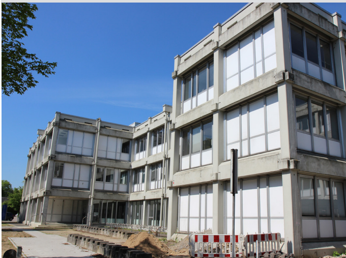
Das Gebäude an der Robert-Koch-Straße 26-28 wird in Kürze zurückgebaut, um Platz für den Hüffer-Campus zu schaffen.
