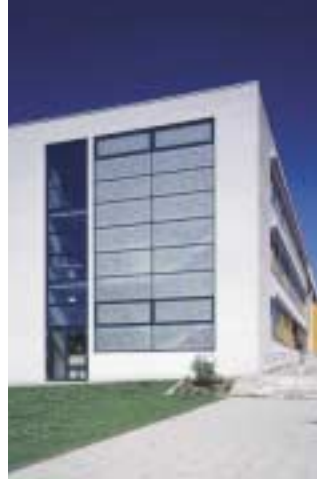
Fachhochschule Gelsenkirchen, Abteilung Recklinghausen Ayse Erkmen, Namenstafel , 1999
