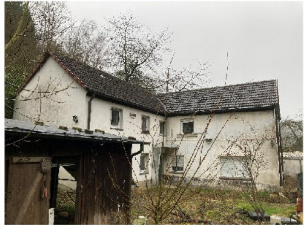
Bild 2: Gartenansicht Richtung Norden
